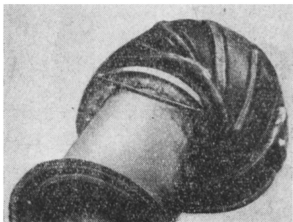
Рис. 31. Монтаж арочной шины.
