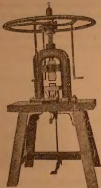
Рис. 35. Каблучный пресс с маховиком (ручной).
