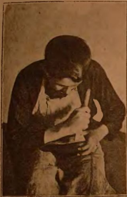
Рис. 71. Обрезывание каблука.
