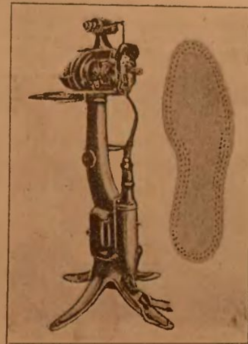
Рис. 33. Деревянно-шпильчатая машина.
