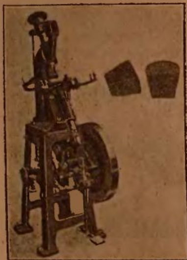
Рис. 34. Машина для сборки каблучков.
