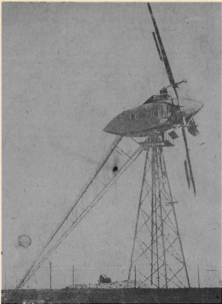
Фиг. 17. Ветродвижитель, D = 30 м, установленный вблизи Балаклавы в Крыму
