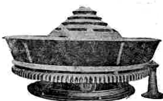
Рис. 83. Механическая решетка Тиссена.
