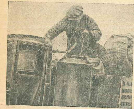
Фиг. 82. Шуровка топлива в газогенераторе.
