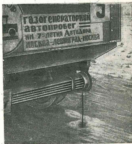
Фиг. 134. Спуск из частей установки выделившейся воды.
