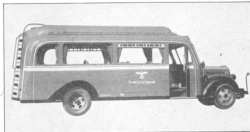
Bild 137: Ford-Omnibus, Bauart Prof. Dr. Deiters, mit Imbert-Generatoranlage
