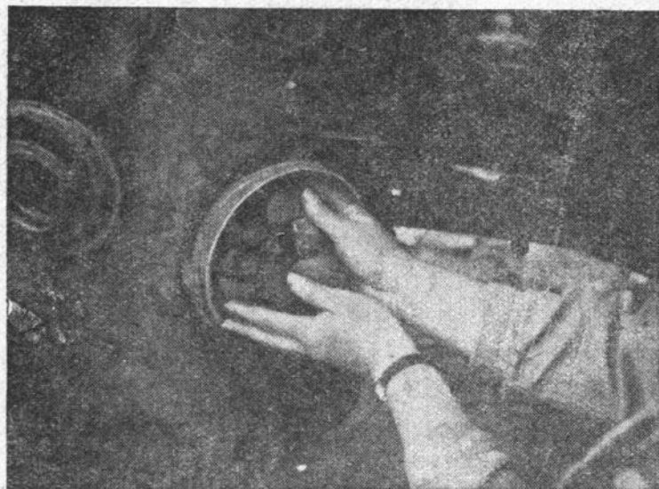
Рис. 3. Заправка углем дополнительной восстановительной зоны вокруг топливника.
