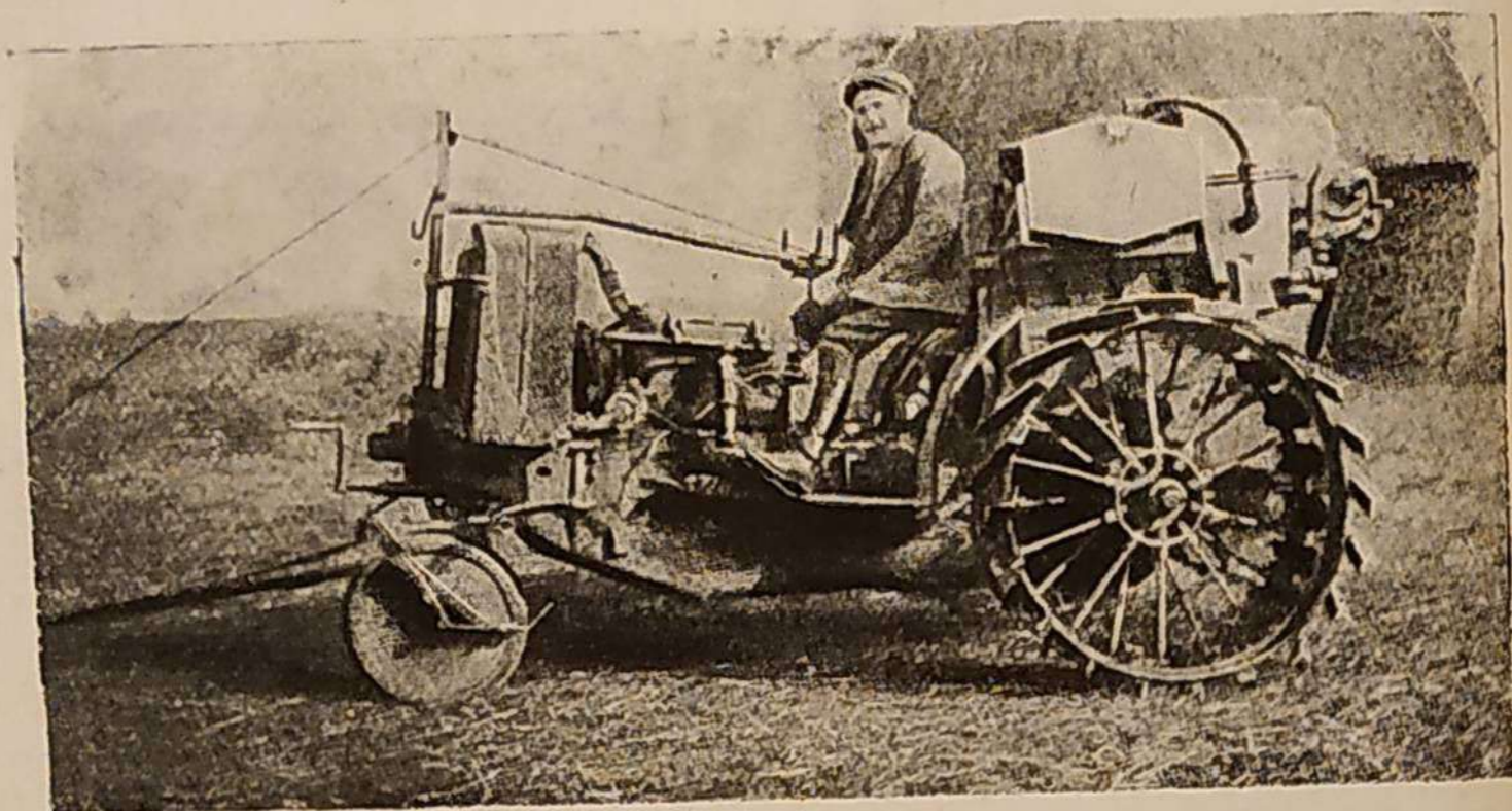
Рис. 25. Газогенератор «Трактор» на тракторе.
