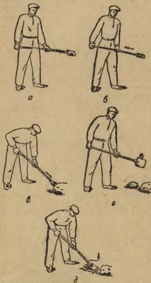
Фиг. 187. Приемы перелопачивания глиняного раствора.
