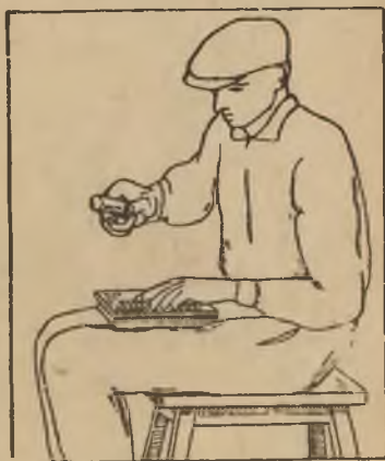
Фиг. 218. Обрубка изразца ножом.
