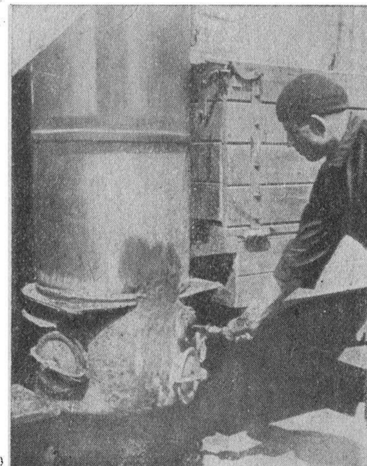
Рис. 27. Розжиг газогенератора.
