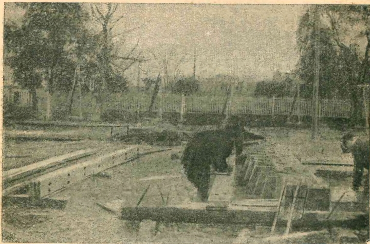
Рис. 40. Деревянный шаблон для выгибания балок
