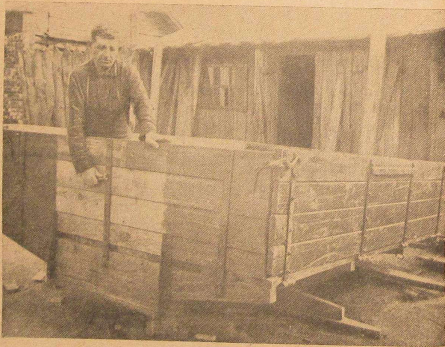
№ 18. Реконструированная передняя стенка кузова. Металлические подставки заменены сплошным деревянным брусом, принимающим на себя всю нагрузку. Предложение тов. Пашука П. С.
