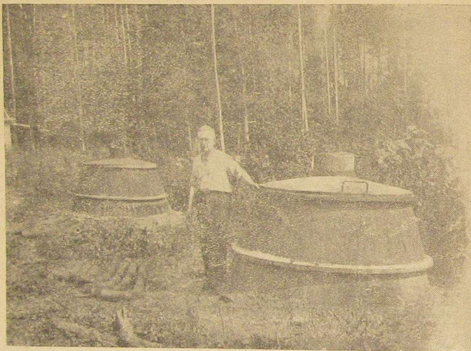
№ 28. Переносные углевыжигательные печи системы ЦНИИМЭ, применяемые также и для подсушки сырой чурки. Активный процесс углевыжигания без доступа воздуха
