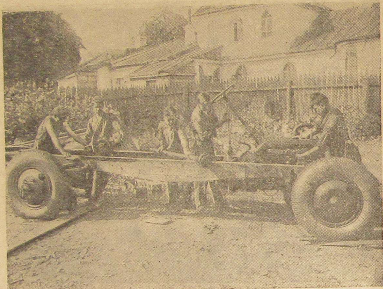
№ 6. VI-я операция: Монтаж
