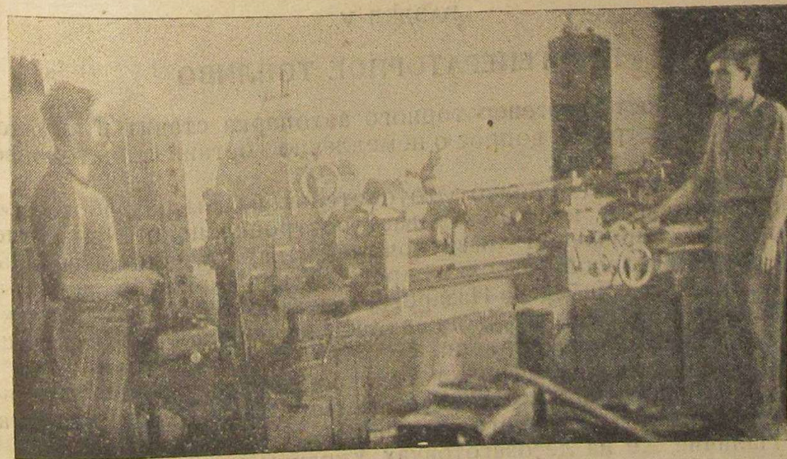
№ 25. Механическая расточка и шлифовка цилиндров двигателя на универсальном станке «Комсомолец» — по предложению тов. Дуса. Справа — стахановец-токарь тов. Дус.
