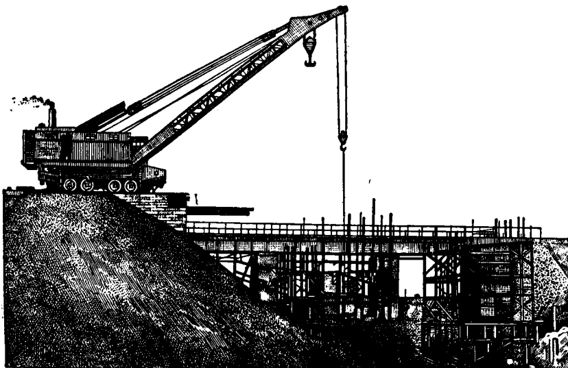
Фиг. 99. Применение крана на строительстве моста
