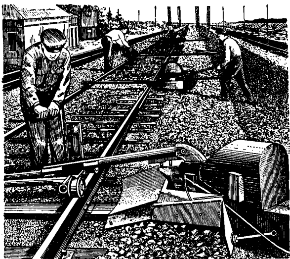
Фиг. 81. Одновременная работа 4-х щебнеочистителей
