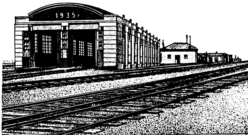
Фиг. 75. Вагоноремонтный пункт постройки 1935 г.
