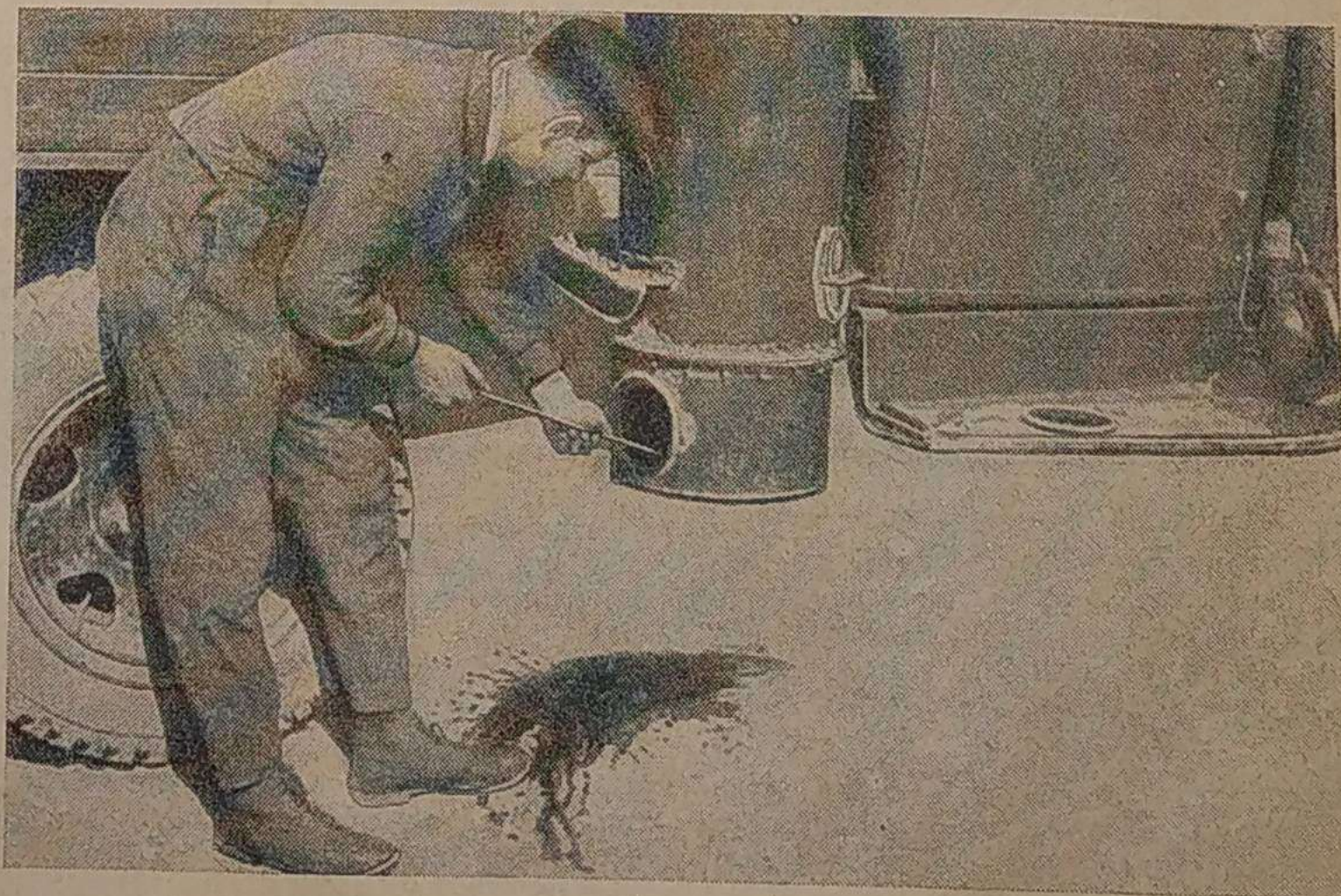
Рис. 2. Очистка поддона тонкого очистителя газа.
