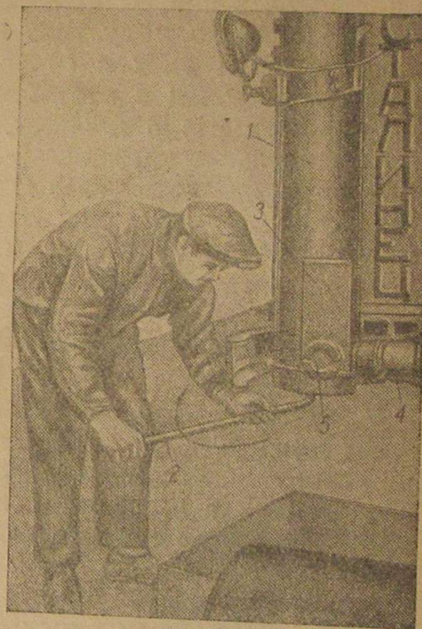
Рис. 20. Выгрузка колец Рашига: 1—первый цилиндр фильтра; 2—ключ для опоры сеток; 3—карман подвода газа; 4—патрубок подвода газа; 5—пробка кармана подвода газа
