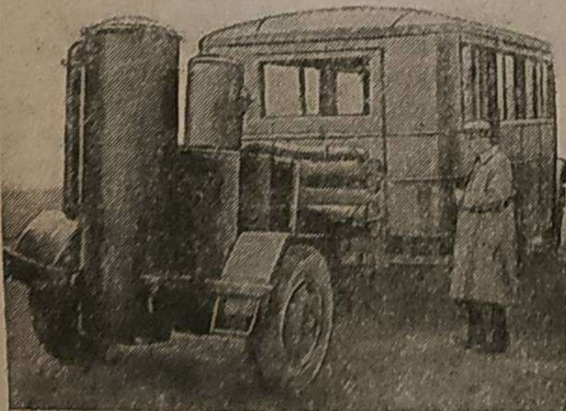
Рис. 1. Автобус с газогенераторной установкой, смонтированной на прицепной тележке.
