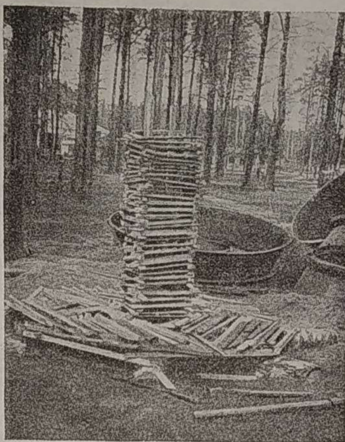
Рис. 1. Постель и колодец, справа — разобранная углевыжигательная печь ЦНИИМЭ
