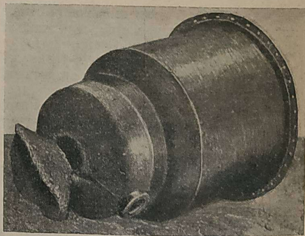
Рис. 2. Прогоревший топливник газогенераторной установки ЛС-1-3
