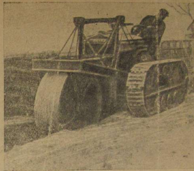
Рис. 6. Утрамбовка дна рва для газопровода.
