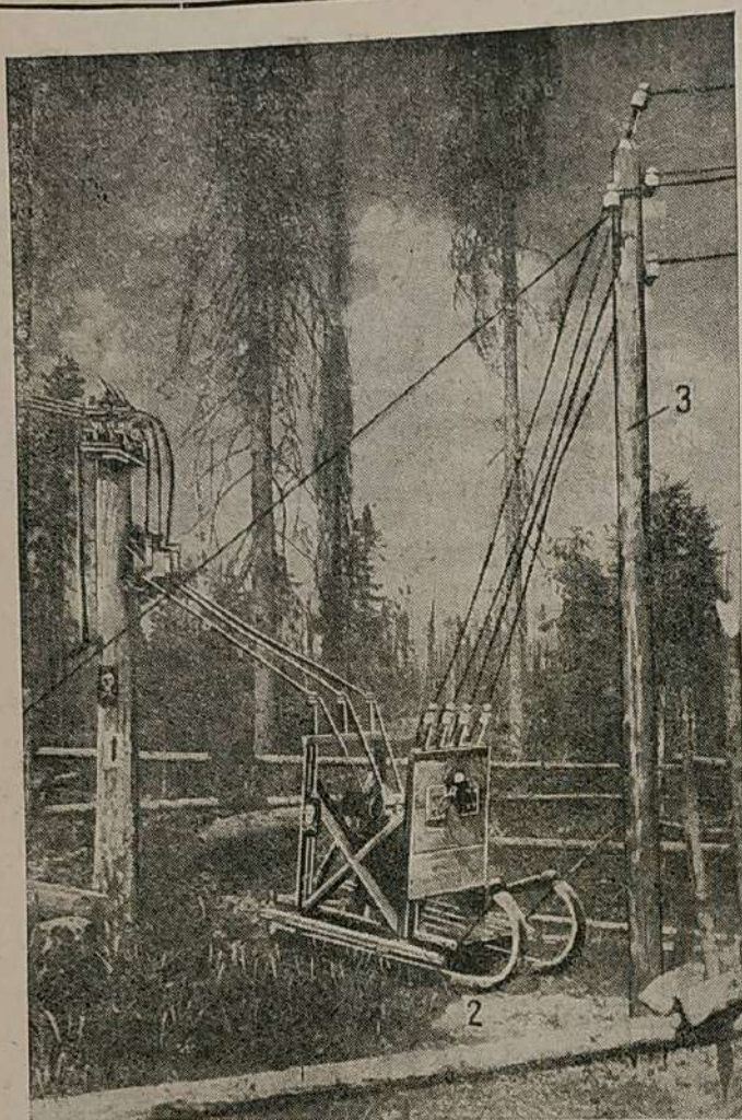
Рис. 1. Трансформаторная подстанция на салазках (Емцовский учебно-опытный леспромхоз):
