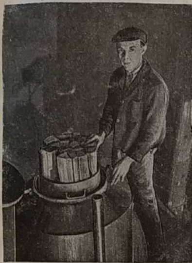
Рис. 3. Загрузка дров в люк газогенератора
