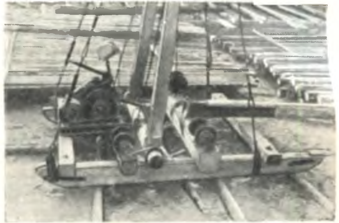
Рис. 2. Рама погрузочного устройства (поворотная стрела опущена)
