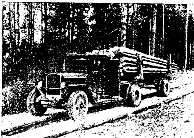
Газогенераторный автомобиль ЗИС-352 на вывозке леса (вид со стороны тонкого очистителя)
