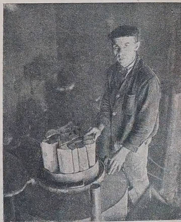
Рис. 3. Загрузка швырка в газогенератор.
