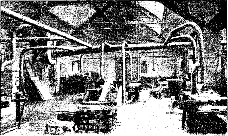
Рис. 37. Деревообделочная мастерская, оборудованная эксгаусторным приспособлением.
