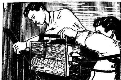
Рис. 254. Монтаж перильного поручня из винипласта.
