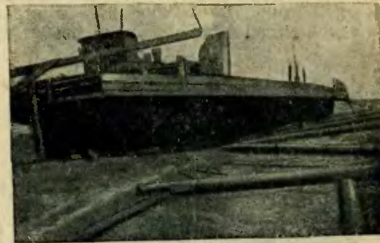
Фиг. 73. Вытаскивание баржи на берег для ремонта черепового бруса
