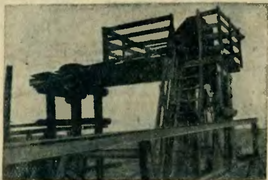
Фиг. 60. Подъёмная вышка переходного мостика
