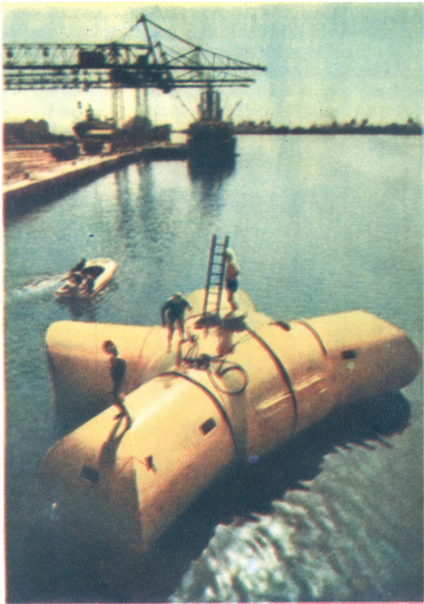
Дом «Звезда» во время сборки. В двух его лучах находятся спальные отсеки, в третьем — размещена лаборатория, а в четвертом — водолазный отсек. В центральном помещении, куда сходятся все лучи, установлен пульт управления и оборудована кают-компания
