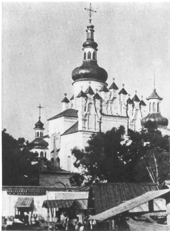
Рис. 17. Церковь Пятницы. Чернигов. Конец XII в. Состояние в довоенное время
