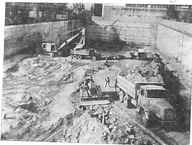
Рис. 82. Общий вид котлована, огражденного «стенами в грунте», закрепленными четырьмя рядами наклонных анкеров
