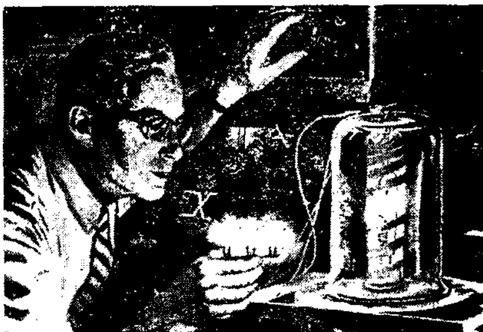
Рис. 1.12. Через электрические лампочки проходит ток, полученный в результате непосредственного преобразования тепловой энергии в электрическую.
