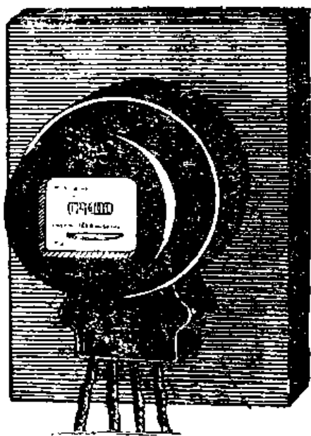
Рис. IV.58. Электросчетчик регистрирует количество израсходованных ватт-часов.
