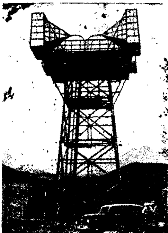
Рис. VI.171. Радиорелейные станции, расположенные приблизительно на 50 км друг от друга, позволяют передавать на большие расстояния телевизионные программы и осуществлять дальнюю телефонную связь. Радиорелейные линии работают на волнах сантиметрового диапазона. Такие волны распространяются прямолинейно, подобно лучам света.
