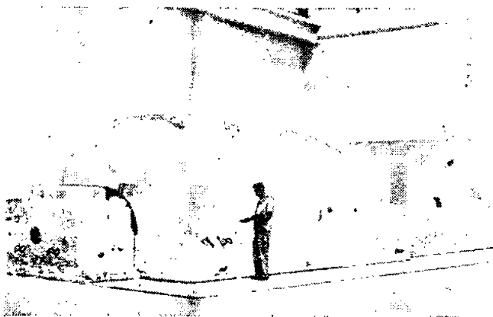
Рис. III.29. Современные электрогенераторы имеют обтекаемую форму и относительно небольшие размеры. Этот генератор, вращаемый паровой турбиной, способен обеспечить электроснабжение города с населением 200 000 человек.
