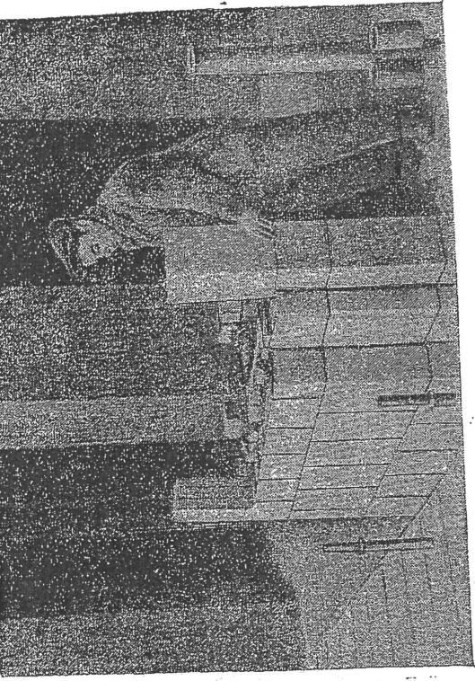
Рис. 51. Установка углового блока
