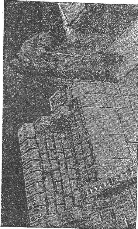
Рис. 53. Проверка установки блока отвесом
