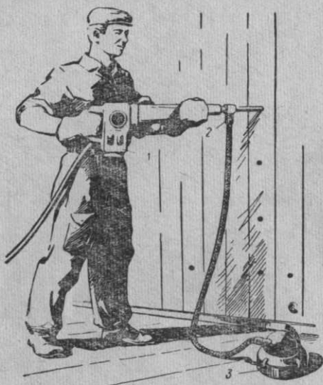
Рис. 13. Применение электролозтки, оборудованного пылесосом, для пробивки отверстий под опорные конструкции шин заземления
