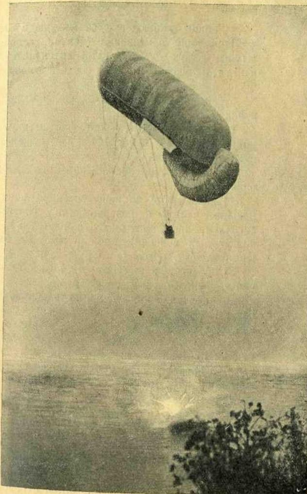
Фиг. 9. Испытание бомб с аэростата.
