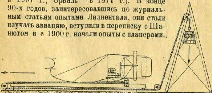
Рис. 6. Схема устройства для подъема самолета Райт.
