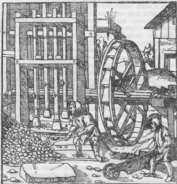
Рис. 9. Машина для дробления руды в XVI веке.
