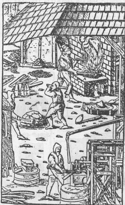
Рис. 6. Плавка металла в штукофене.
