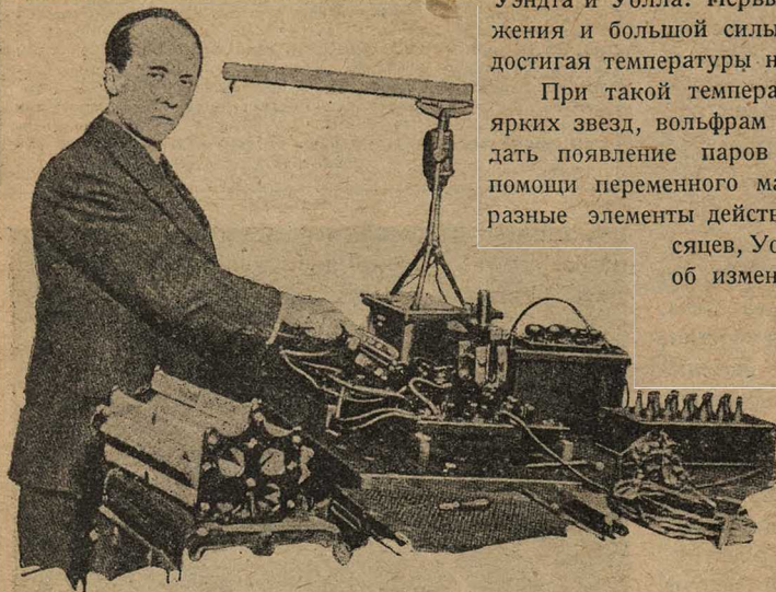
Проф. Уолл в своей лаборатории около установки для разложения атома с помощью сильного переменного магнитного поля. В ничтожную долю секунды аппарат этот может сообщить катушке эквивалент энергии в 200 000 лошадиных сил. Это интенсивное магнитное поле действует регулярно в течение дней, недель и даже месяцев на вещество, атомную структуру которого хотят изменить.
