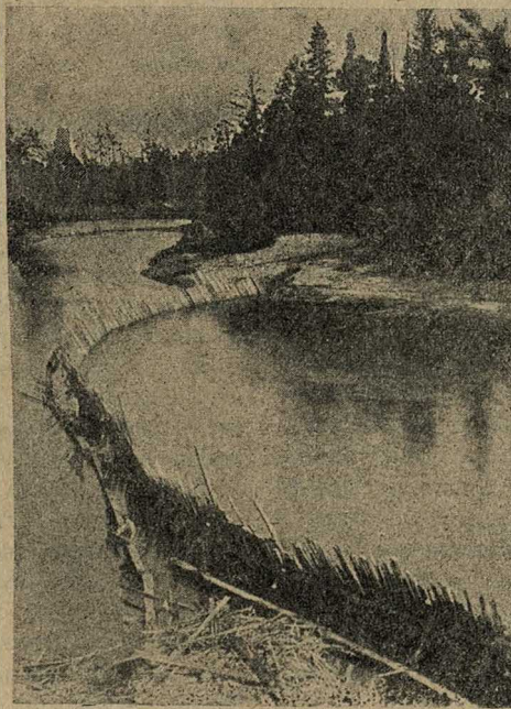
Весенний закол на р. Евре. Река перегорожена не по кратчайшему расстоянию — поперек, а по дуге, для того, чтобы все пайщики могли установить вдоль этой удивленной перегорожки свои снасти.
