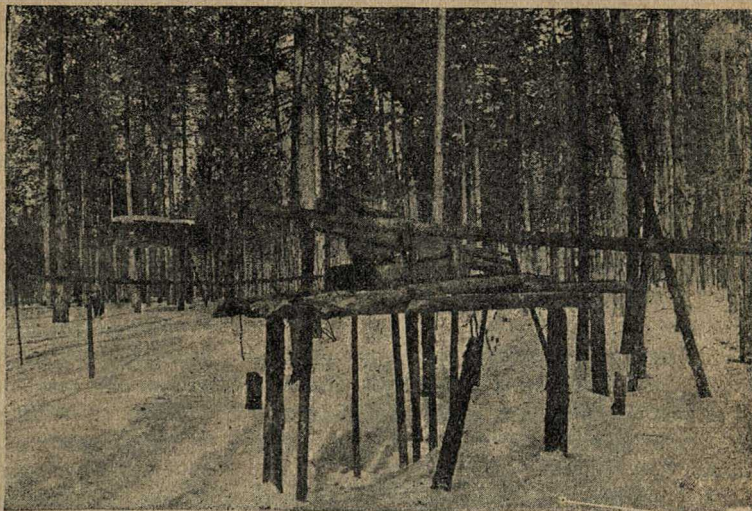
Пример охотничьей хитрости вогулов. Сваи ловушки-слопцы для росомах они строят неподалеку от амбаров, придавая им внешнее сходство с последними. На переднем плане—ловушка-слопец, слева, в глубине—свайного типа амбар на высоких столбах.
