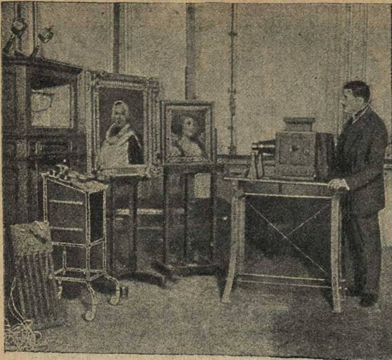
Кабинет художественной экспертизы при помощи X-лучей при Луврском Музее. У аппарата проф. Соллернер.
