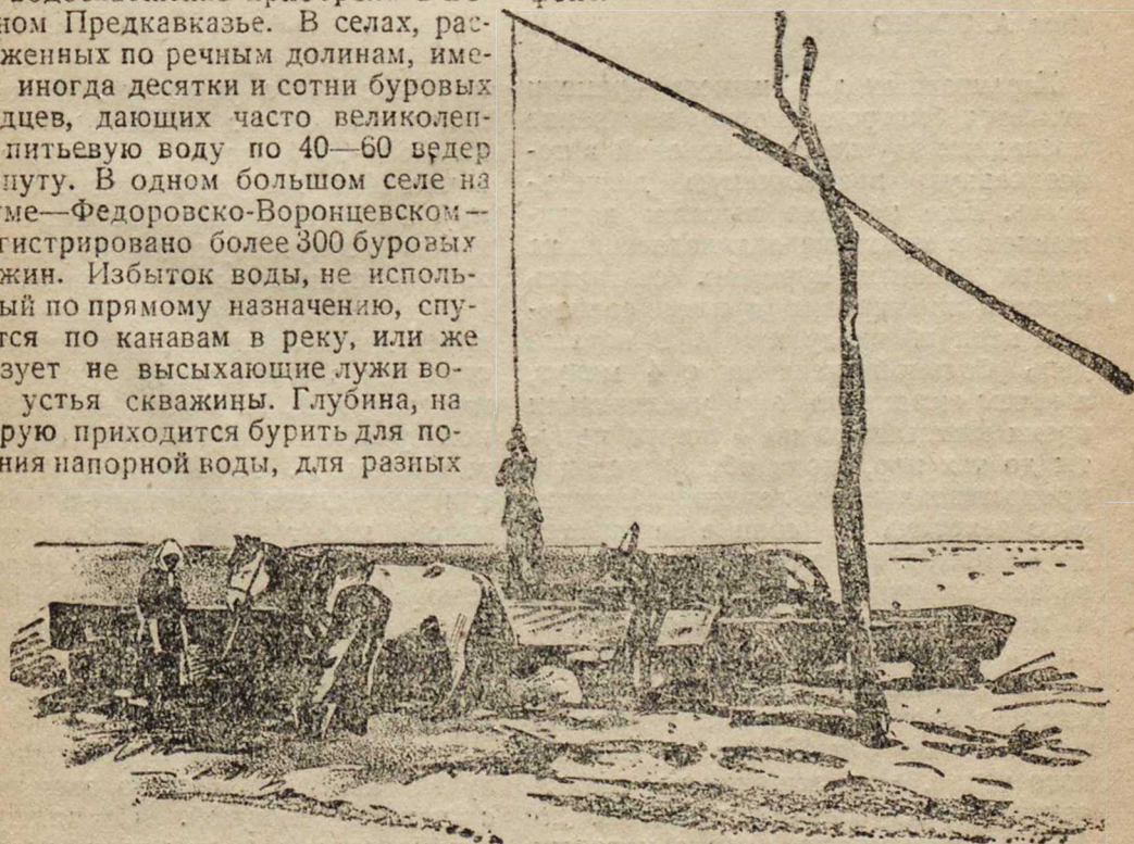
„Уравль“ — приспособление для подъема воды из мелких колодцев (8—12 м)
