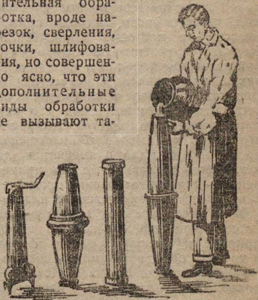
Отливка проходных изоляторов из карболита на Дубровском заводе "Карболит"
