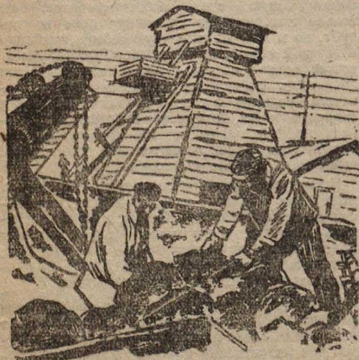
Работы по проходке шахт Кмастрой
