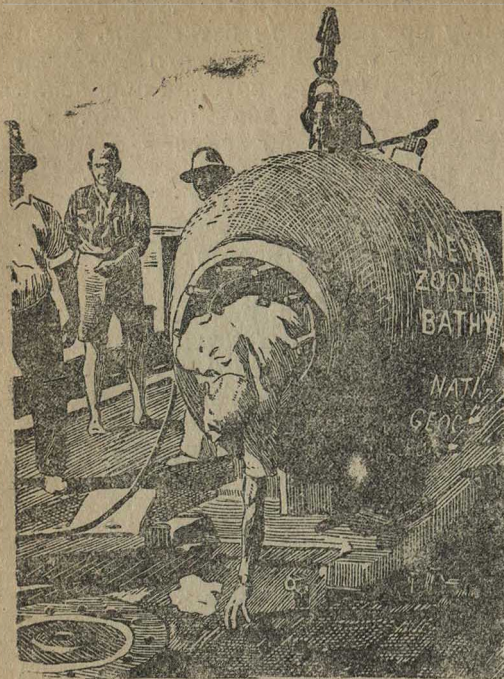
Д-р Бибб покидает батисферу после подъема на палубу. В левом углу рисунка — крышка входного люка. Болты делают выход из батисферы весьма затруднительным.
