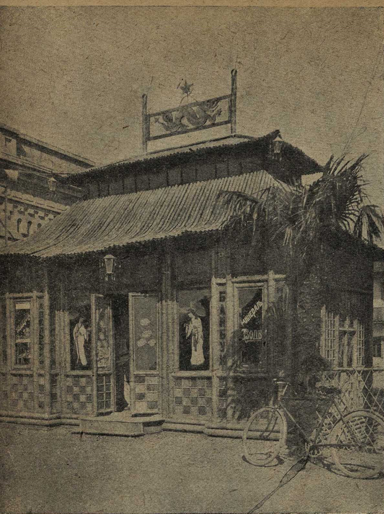
Применение бамбука в строительном деле. Бам- буковый киоск на стан- ции Чаква 3, ж. д.
